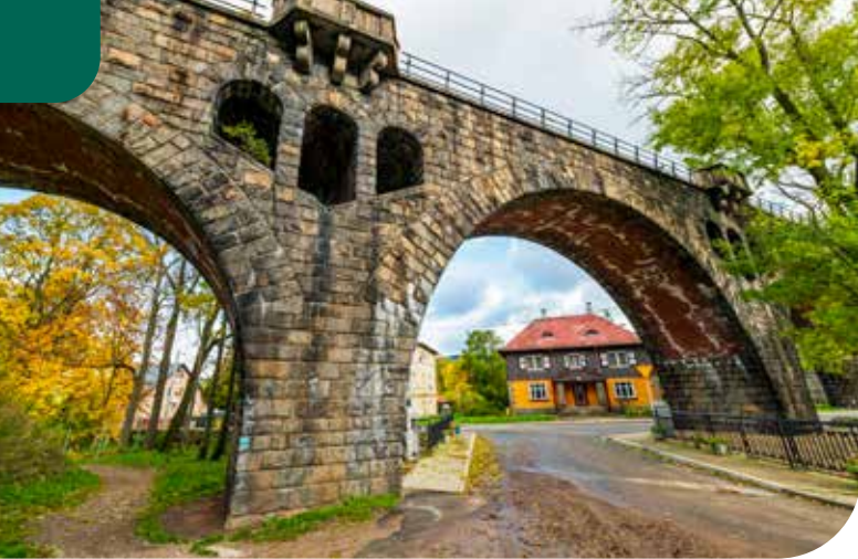
Wiadukt kolejowy nad ul. Wiejską (fot. R. Kotylak)
