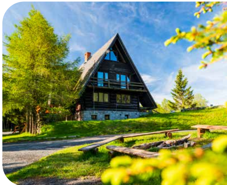
Schronisko PTTK Na Przełęczy Okraj (fot. R. Kotylak)
